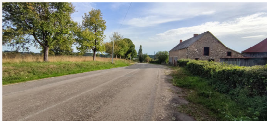
Absence de trottoirs et d'aménagements cyclables (SCE)
