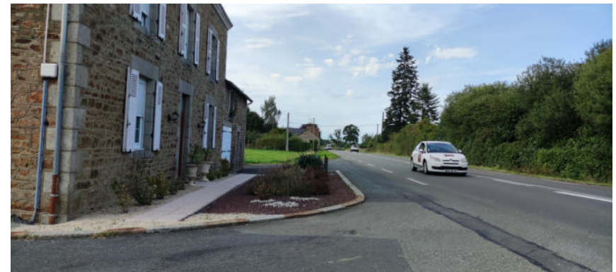
Des habitations ayant un accès et une vue directe sur la RD31 (SCE)
